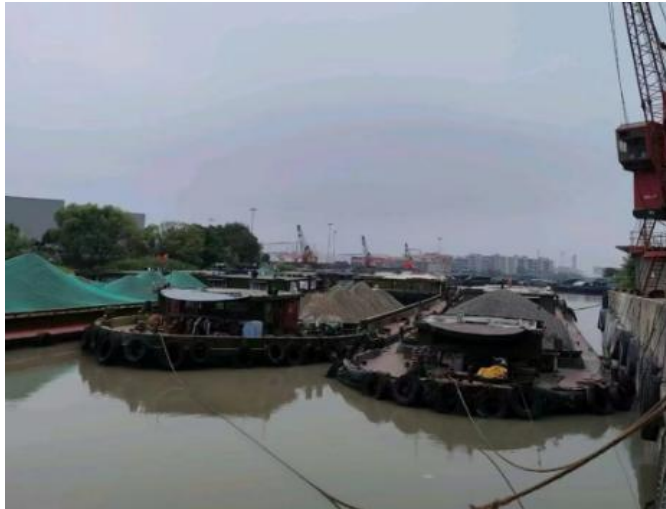
项目西侧（东大港）
